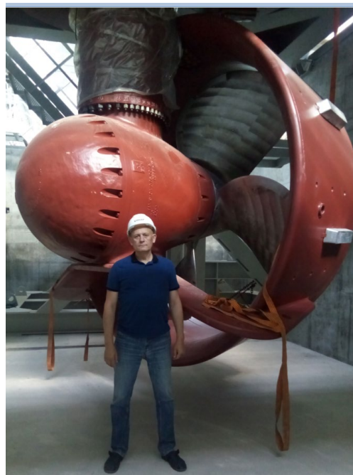
Монтаж на судне г. Ярославль
